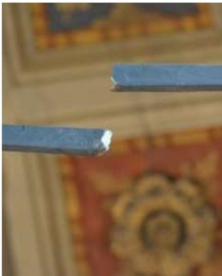
A causa delle tensioni riscontrate all'interno della Chiesa in oggetto, dovute alle forze applicate al campanile ottocentesco, si è prodotta una rottura del tirante in corrispondenza dell'abside.
